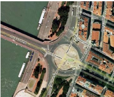
Lyon / Place Jutard / AVANT TRAVAUX
