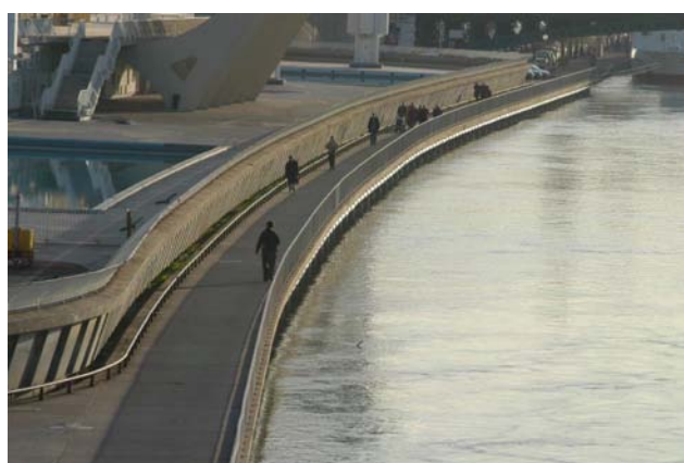
Berges du Rhône Elargissement en encorbellement
