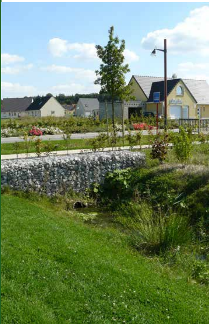
Traitement paysager d'une noue Source : gestiondifférenciée.org
