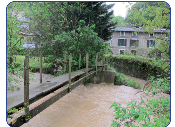
Crue de la Sévenne dans la montée de Leveau à Vienne, mai 2013, M. Jacques - Dauphiné Libéré
