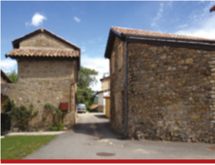
Constructions de 2 niveaux, hameau de l'Olagnière à Saint Michel sur Rhône
