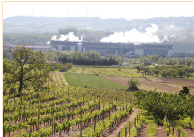
Centrale de Laveyron en arrière-plan des vergers d'Andance
