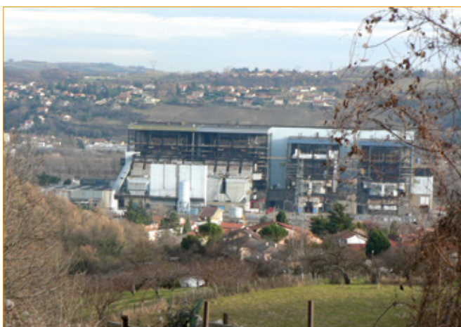
Centrale thermique de Loire-sur-Rhône en cours de déconstruction (2013)
