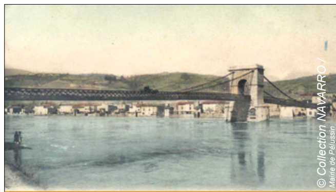
Pont de Condrieu élevé en 1832 remplacé par l'actuel pont routier en 1930
