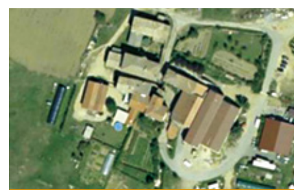
Hameau Le Montélier, Chavanay : une forme compacte et des volumes imbriqués les uns dans les autres
