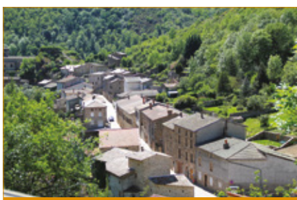
L'enfilade de bâtiments organisés autour de la rue centrale
