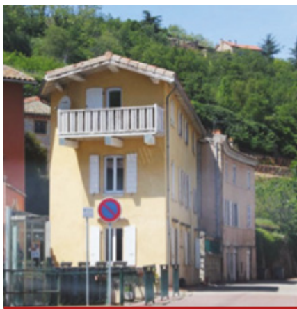
Bâtiment aux fenêtres de faible hauteur au dernier niveau
