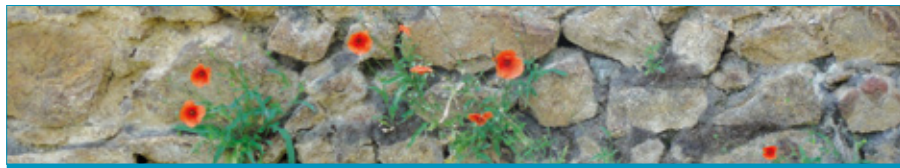
Les murs en pierres sèches, des supports de biodiversité à maintenir
