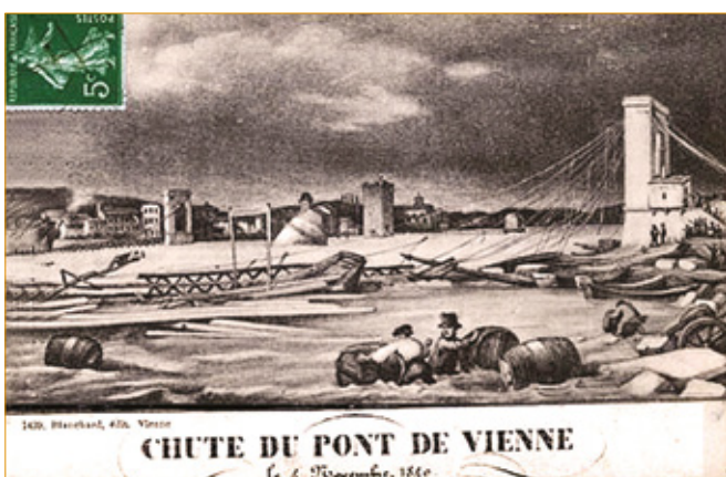
Passerelle piétonne entre Sainte-Colombe et Vienne
