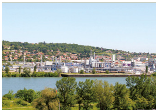
Usine chimique des Roches-de-Condrieu et ses structures métalliques
