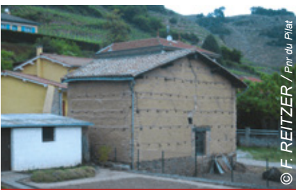
Construction en pisé dans le bourg d'Ampuis
