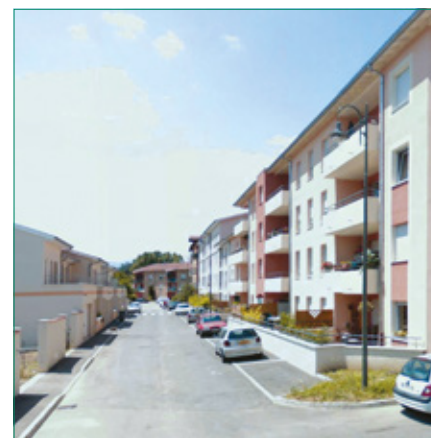
Opération de renouvellement urbain et densification du bourg à Ampuis
