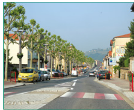
Requalification de la traversée de bourg et du profil de voirie de la RD à Ampuis pour sécuriser le cadre de vie des habitants (ralentissement du trafic, traitement des entrées de ville, faciliter les traversées de la voie, limiter les nuisances sonores...)
