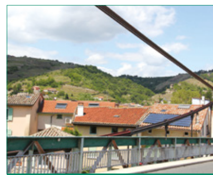
Pont de Condrieu, des espaces de trottoir très étroits
