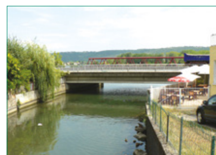
Aménagement de bords de ruisseau canalisé à Verin
