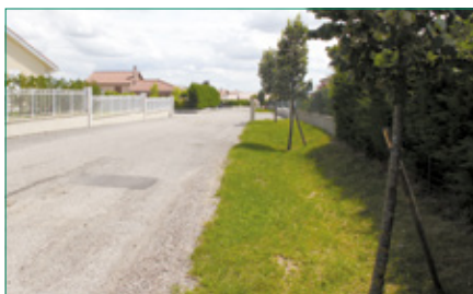
Gestion des eaux pluviales à ciel ouvert par des noues au sein des nouvelles opérations
