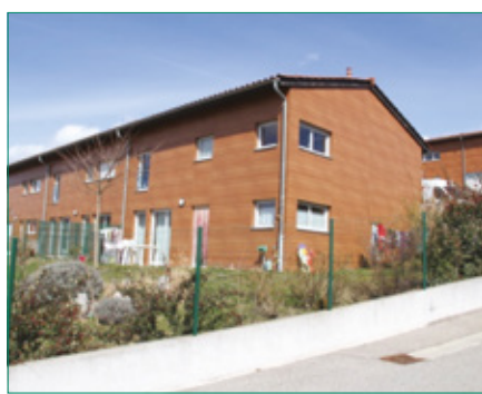
Habitat groupé, économe en énergie et intégré à la pente (Condrieu)
