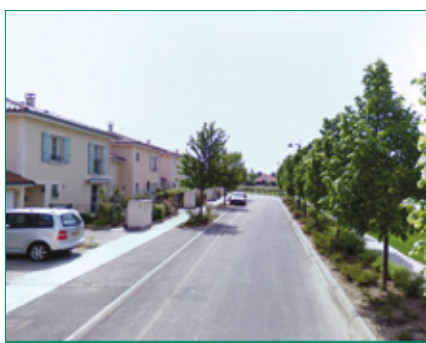
Exemple de traitement d'urbanisation en bordure d'espace vert à Corbas (69)
