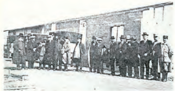
20 - 1915, les officiers, sous et militaires, sur le chantier de la nouvelle usine.
