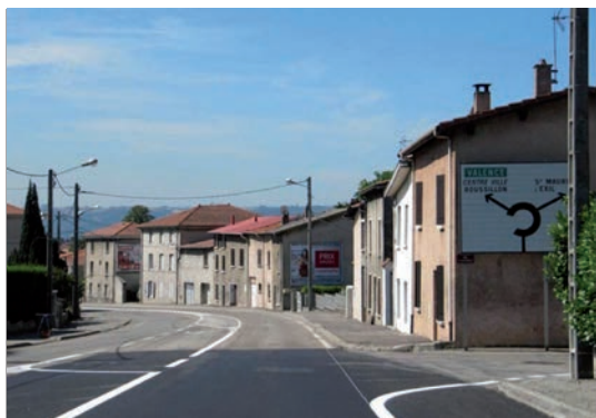
La RN7 au Péage-de-Roussillon, état existant
