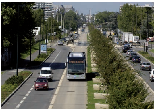
Aménagement d'un Bus à Haut Niveau de Service (BHNS) : exemple du busway de Nantes (44)
