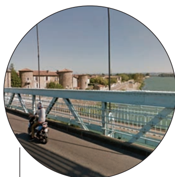
Mise en valeur du pont (peinture / mise en lumière).
