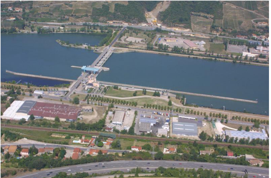
Barrage de Vaugris
