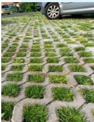
Stationnement végétal avec des dalles alvéolaires béton. Remplissage des dalles avec du gazon et gravier (au dessus) ;
