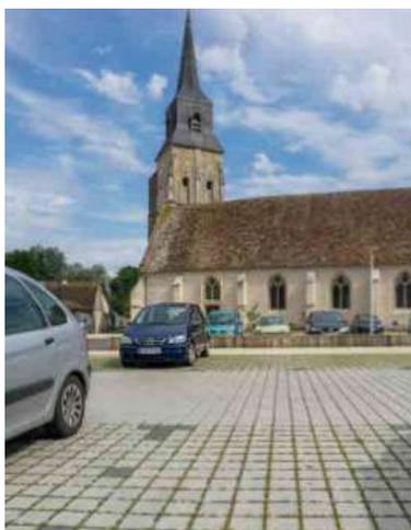
Stationnement minéral avec des dalles alvéolaires béton et d'un remplissage minéral (au dessus) ; Stationnement avec des pavés béton avec joint enherbés (à gauche).
