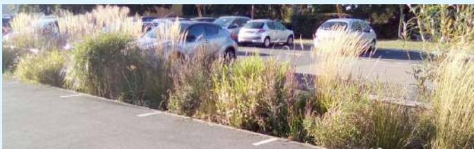
Parking avec tranchée infiltrante (à gauche) ; Parking arboré avec stationnement perméable réalisé par l'atelier Paul Arène (à droite)
