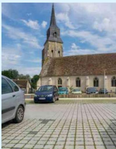
Stationnement minéral avec des dalles alvéolaires béton et d'un remplissage minéral (au dessus) ;
