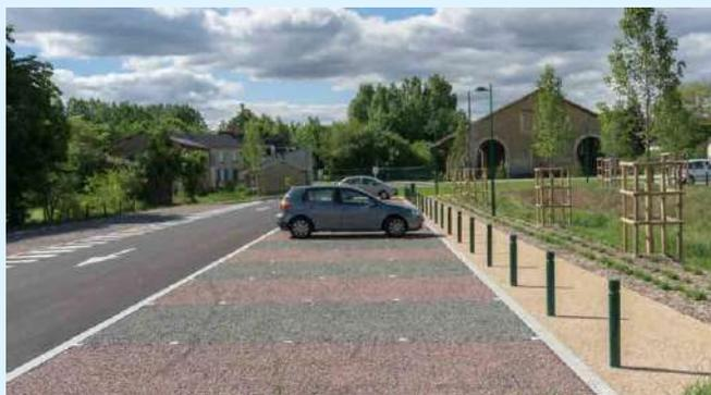
Stationnement minéral avec des dalles alvéolaires béton et d'un remplissage minéral (au dessus) ;
