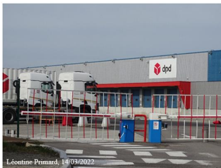
Figure 36 : Site Logistique Axe 7 Saint-Rambert-d'Albon
