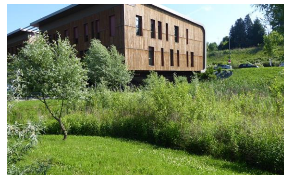
Exemple bassin d'infiltration végétalisé
