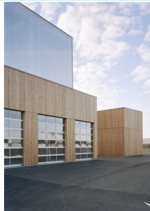
Des bâtiments sobres et efficaces
