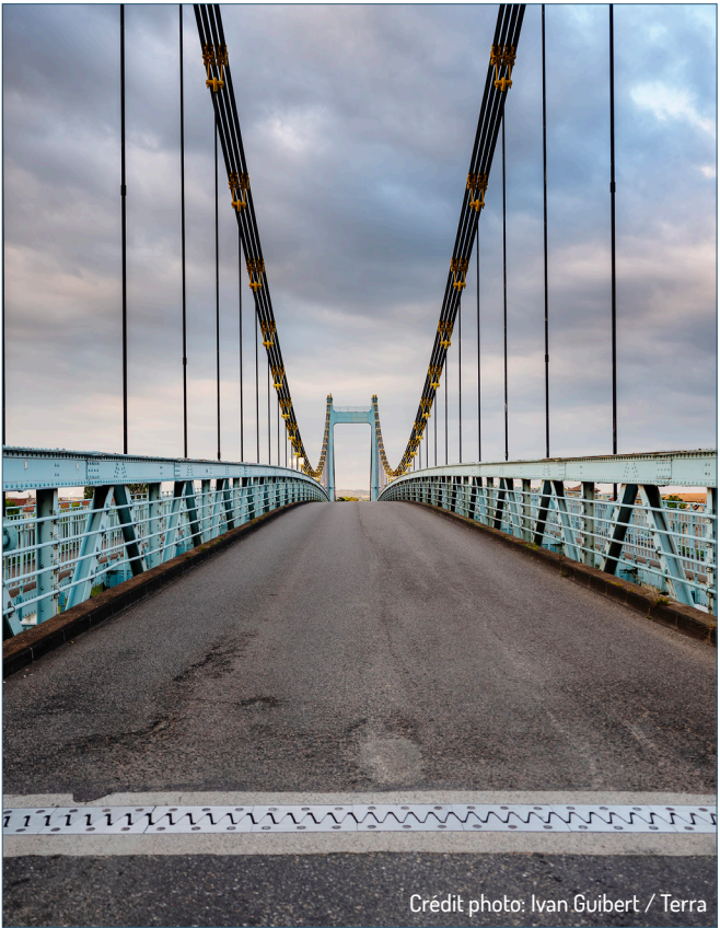
Pont routier de Sablons-Serrières
